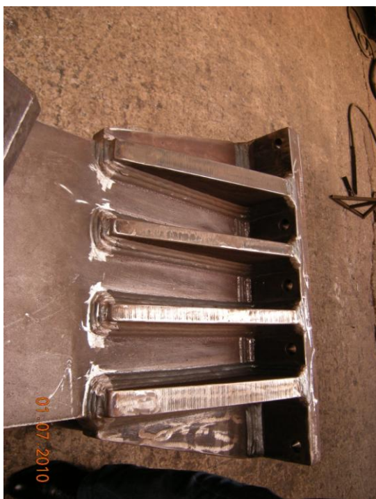
Verifica in officina delle saldature del pilastro
