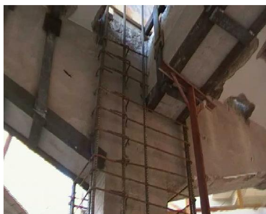
Particolare armatura pilastro e consolidamento delle travi
