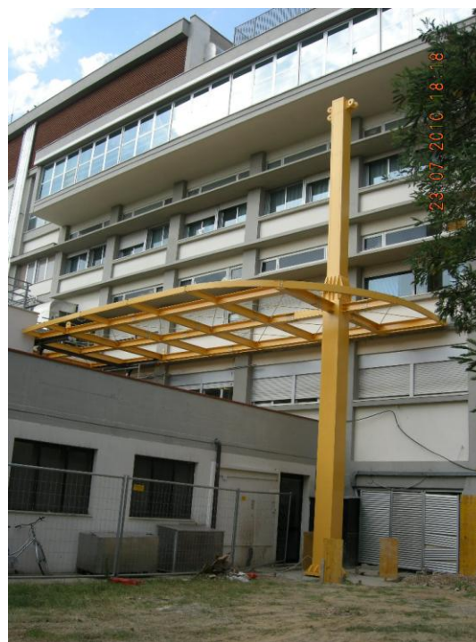
Vista della struttura in acciaio montata
