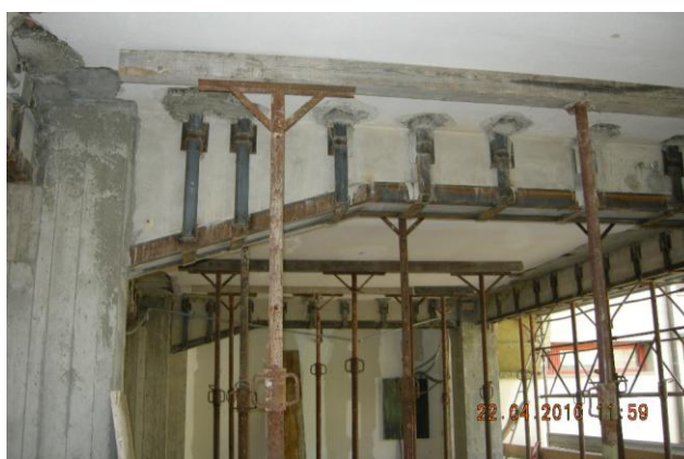
Particolare armatura pilastro e consolidamento delle travi
