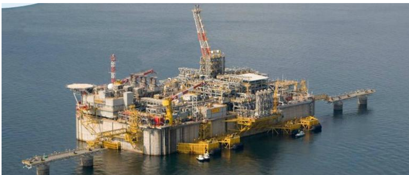
Impianto di rigassificazione dell'Alto Adriatico: lavori ultimati
