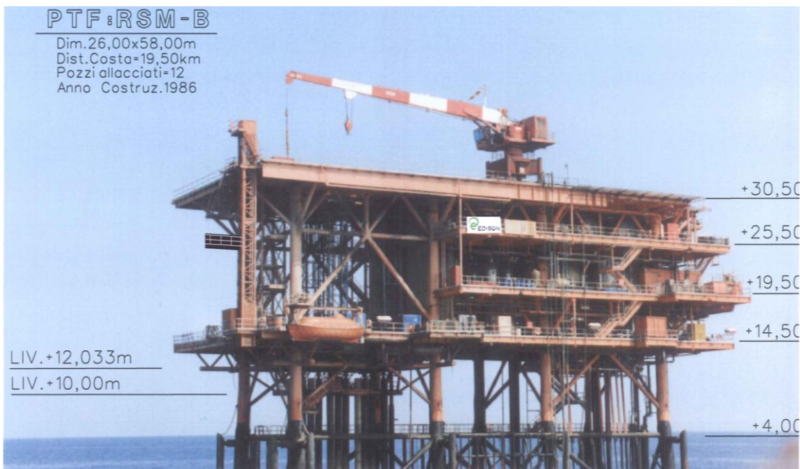
Piattaforma fissa Rospo Mare B
