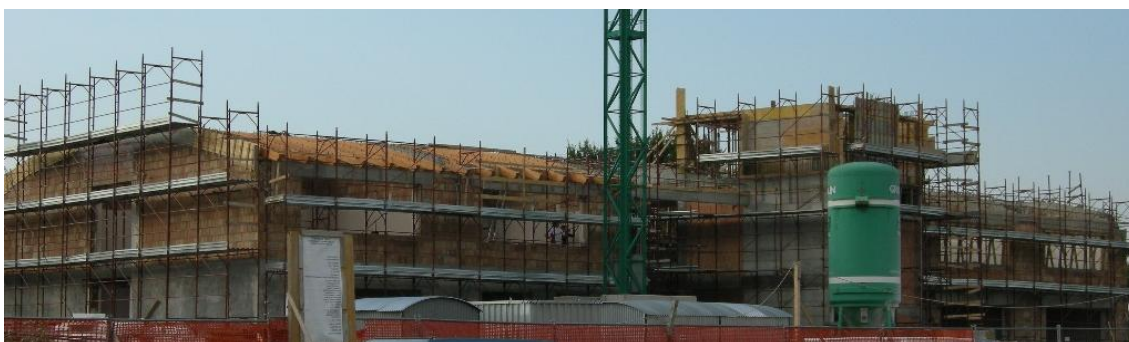
Vista della scuola di Vergaio-Tobbiana in costruzione
